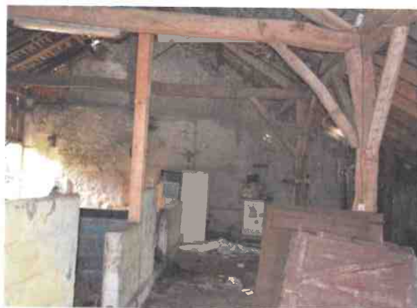
État général de la couverture, traces d'infiltration d'eau
