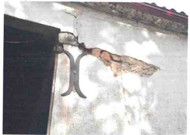
Ancres avec tirants, mur pignon sud-ouest et mur façade nord-ouest
