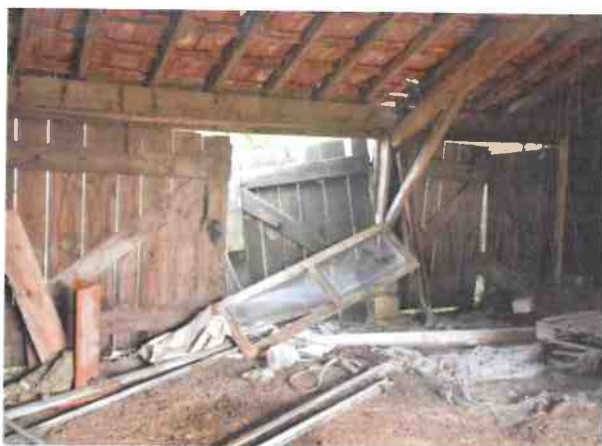
État général de la couverture, traces d'infiltration d'eau
