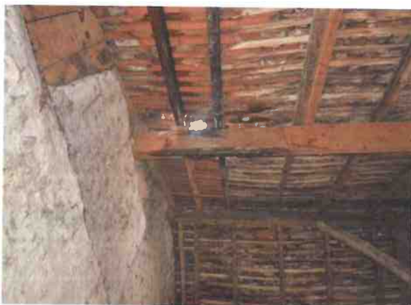
Traces d'infiltration d'eau
