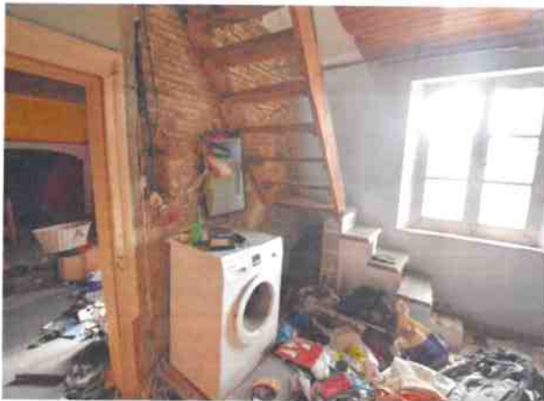
Chambre 2 (R+1), fils électrique sans protection
