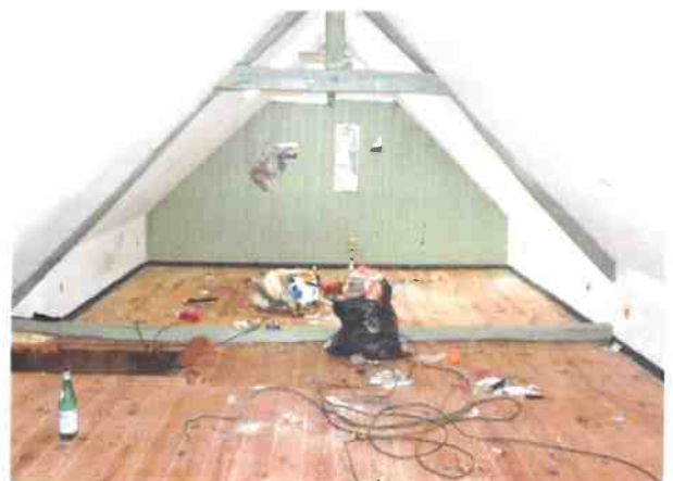
Chambre 2 (R+1), fils électrique sans protection
