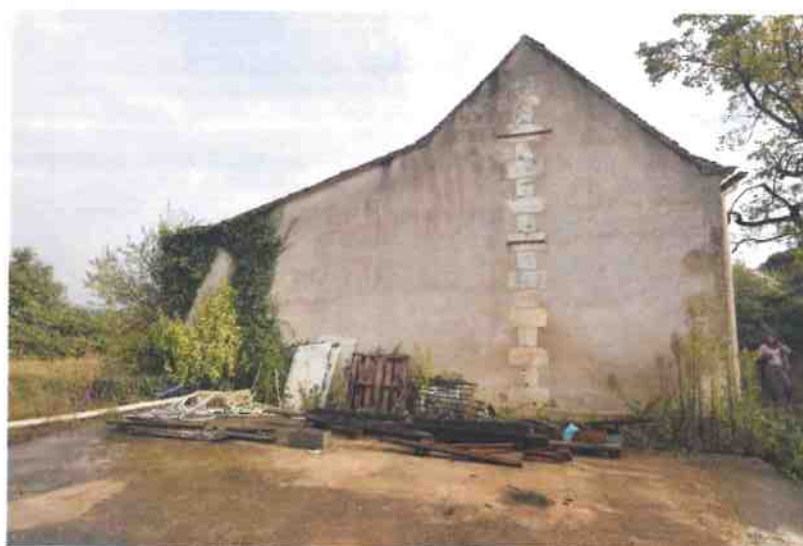
Pignon sud-ouest (grange 1)
