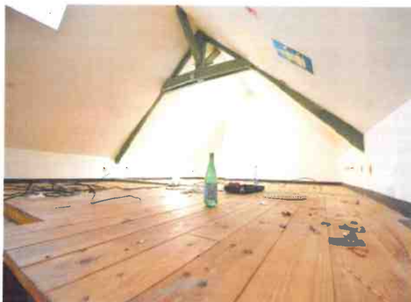
Chambre 2 (R+1), fils électrique sans protection
