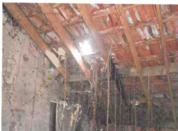
Traces d'infiltration d'eau
