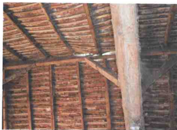
Traces d'infiltration d'eau
