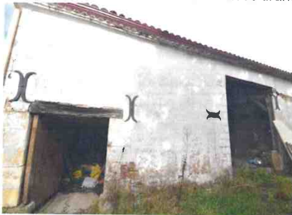
Ancres avec tirants, mur pignon sud-ouest et mur façade nord-ouest
