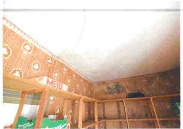
**Tube métallique vétuste et obsolète, fissurations et traces d'humidité en murs et plafond**
